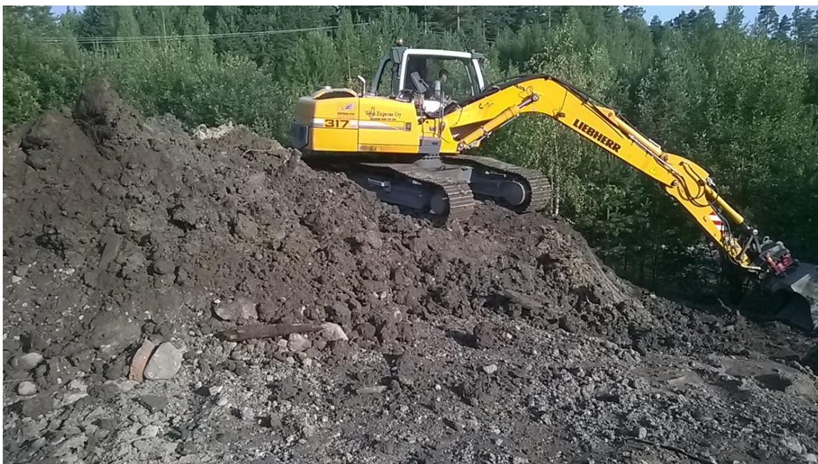
Kuva 3. Tilannekuva savimaan kaivutyöstä osoitteessa Ristinummentie 121.
