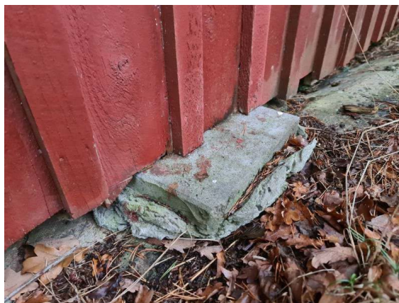
Bilder 15 och 16: Grunden till Helmis stuga har reparerats och ändrats. (Källa: Byggnadens konditionsbesiktning 2021)
