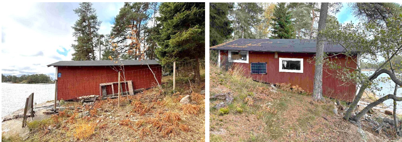
Bilder 38 och 39: Till vänster det äldre, mindre båthuset sett från norr, och till höger det nyare båthuset från motsatt håll, söderifrån. Båthusen är traditionellt byggda för att "sjunka" in i strandbranten; enligt byggnadssätt och användningsändamål fortsätter marken sluttande även inuti båtstallet. (Fotografier: P. Eriksson 2025)
