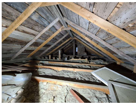
Bilder 17 och 18: Helmis stugas bottenbjälklag har förnyats med material innehållande plast. Övre bjälklaget har förnyats och isolerats med mineralull. (Källa: Byggnadens konditionsbesiktning 2021)
