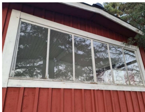
Bilder 19 och 20: Fönstren och ytterdörrarna har bytts ut och ändrats på 1980-talet. Även fasadbeklädnaden har bytts ut, med undantag för beklädnaden på gaveltriangeln. (Källa: Byggnadens konditionsbesiktning 2021)
