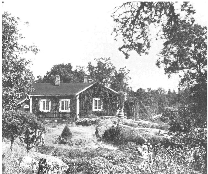
Bild 13: Merus stuga under Gösta Stenmans tid, fotograferad från söder (från boken Porkala – bygd i förvandling (2008)).
