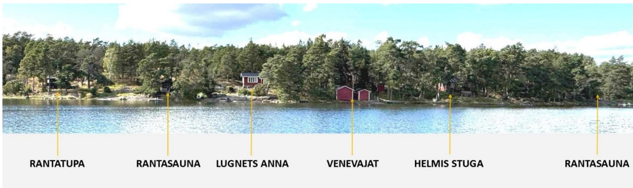
Kuva 14: Suunnittelualueen rakennukset vuonna 2025
