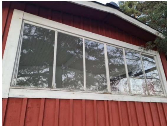
Kuvat 19 ja 20: Helmin tuvan ikkunat ja ulko-ovet on uusittu ja muutettu 1980-luvulla. Myös ulkoseinäverhous on uusittu, lukuun ottamatta päätykolmioiden verhousa. (Lähde: Rakennuksen kuntotarkastus 2021)
