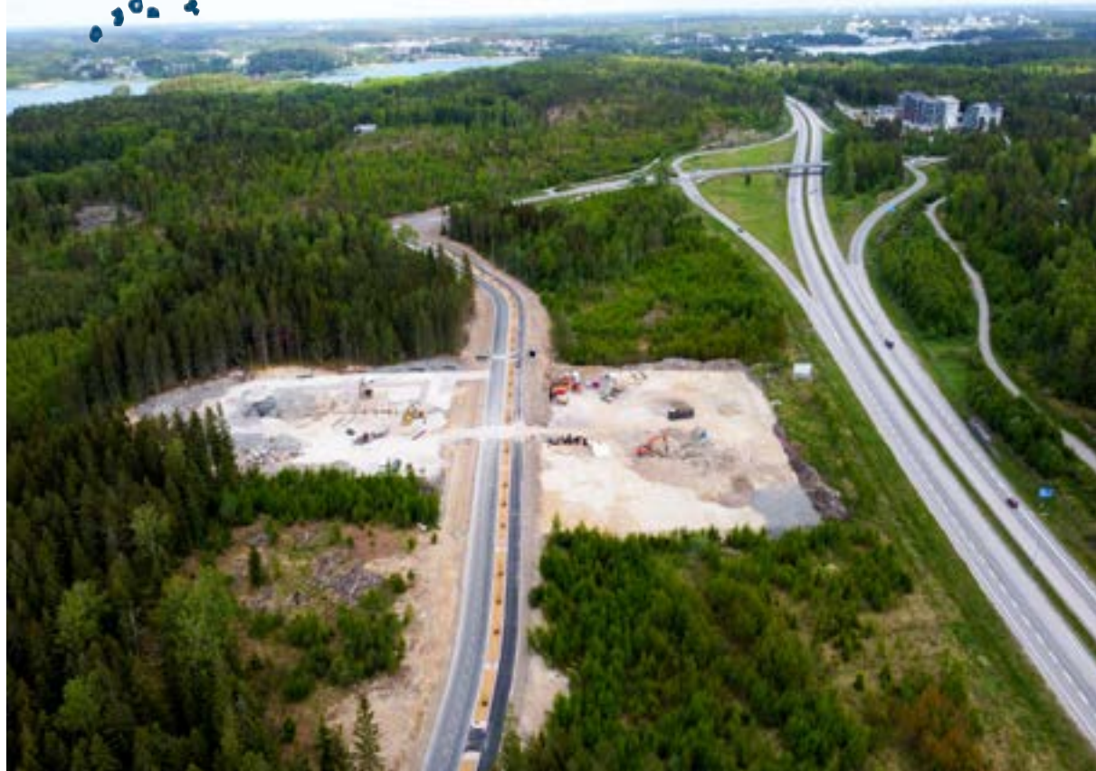
Byggandet av datacentralen och dess närområde har framskridit (bild år 2023).
