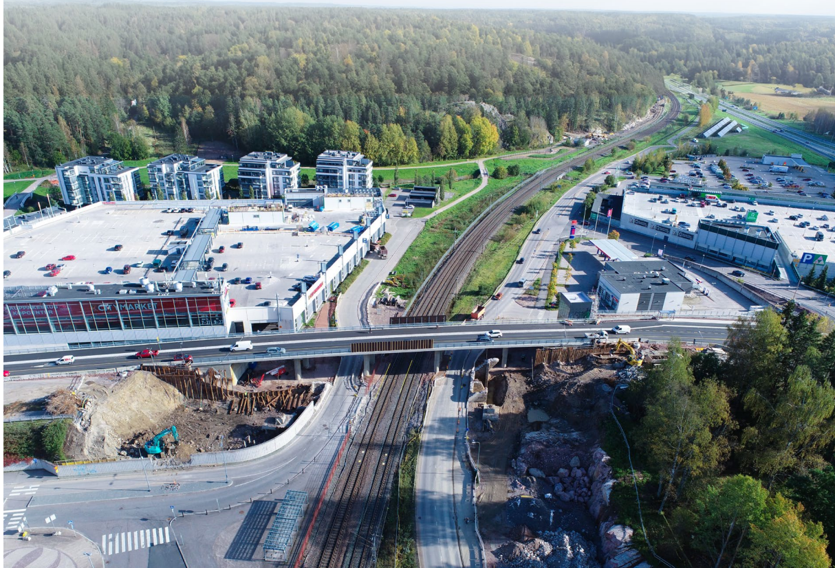
Kyrkslättsvägens bro färdigställs före utgången av år 2024.
