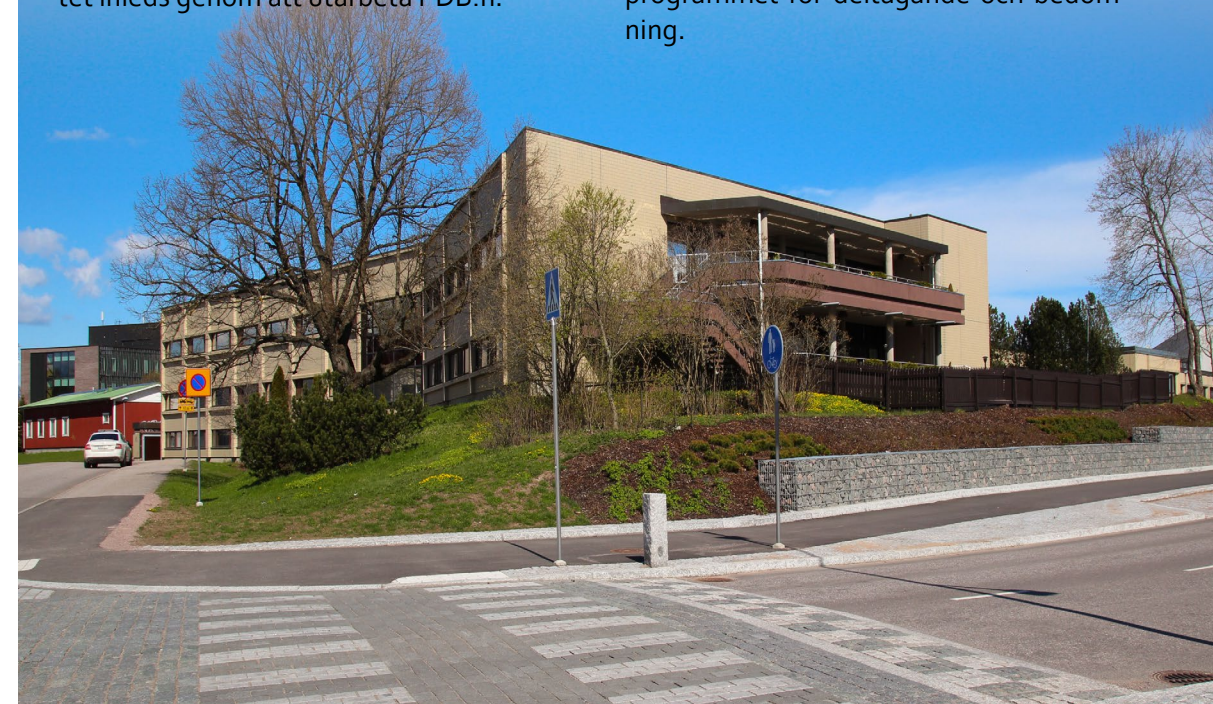
Gamla hälsocentralen väntar på rivning.
